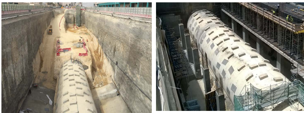
Figura 10. Ejecución de solera y de estructura interior de la estación
