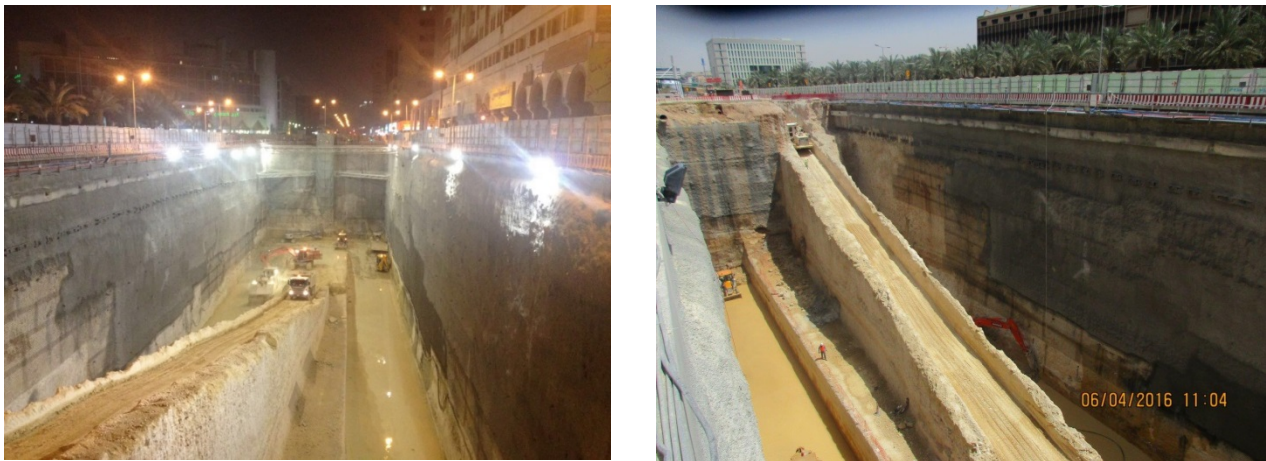
Figura 12. Estación en excavación, rampa sobre el túnel
