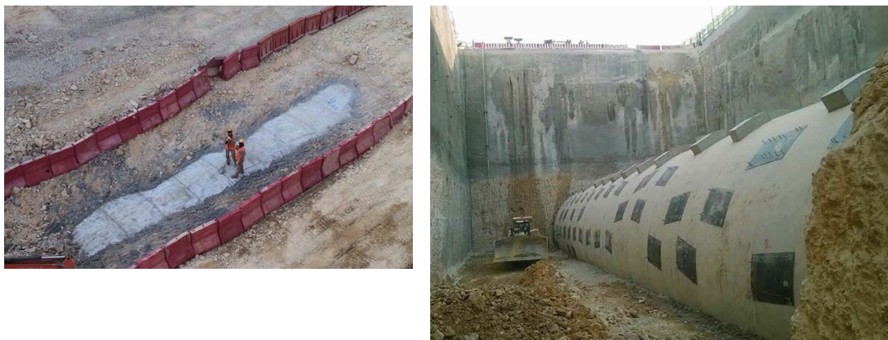
Figura 9. Descubrimiento de la clave del túnel y excavación
