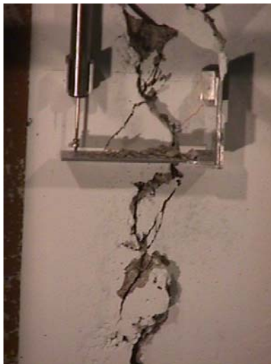
Junta antes de romper. Aún resiste carga máxima
