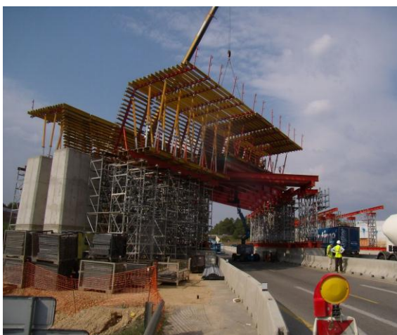
Figura 10: Vista del montaje de la cimbra aporticada.
