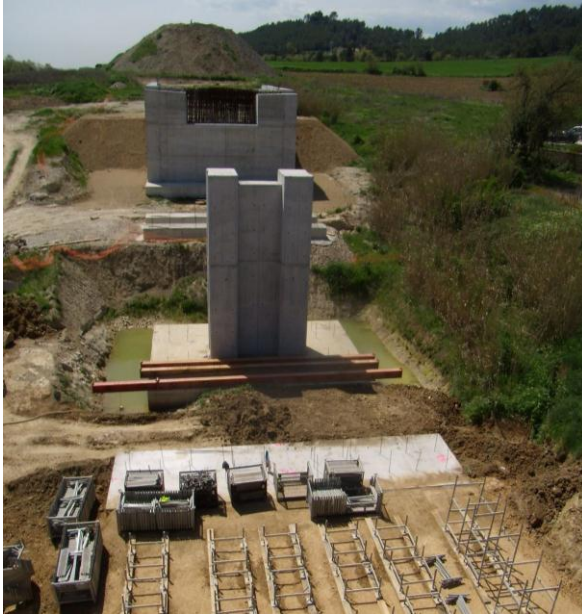
Figura 3: Vista desde Pila 4 del colector de aguas pluviales situado entre pilas del viaducto sobre la C-66.
