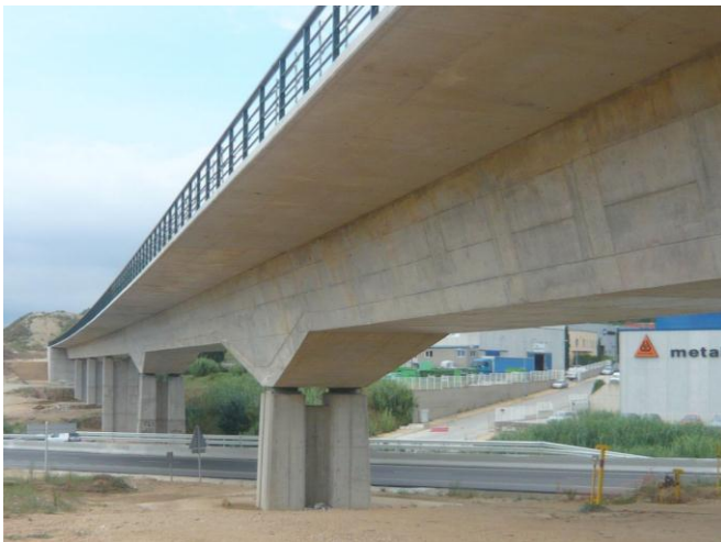
Figura 4: Vista general de la estructura en el cruce C-66.
