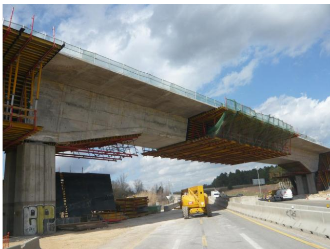
Figura 5: Descimbrado vano sobre carretera C-66.
