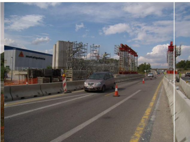
Figura 9: Vista de las torres de la cimbra porticada.
