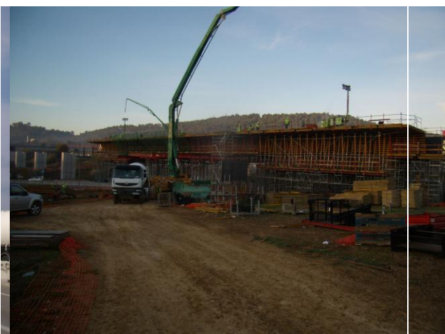
Figura 11: Vista de la cimbra cuajada del vano 6.
