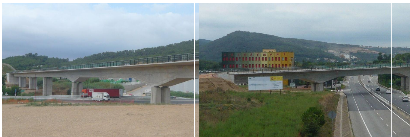
Figuras 1 y 2: Vista general de la estructura con el cruce sobre los distintos viales.
