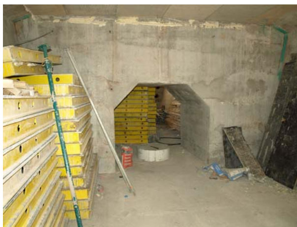
Figura 3: traviesa de apoyo en pila con huecos para paso de hombre.
