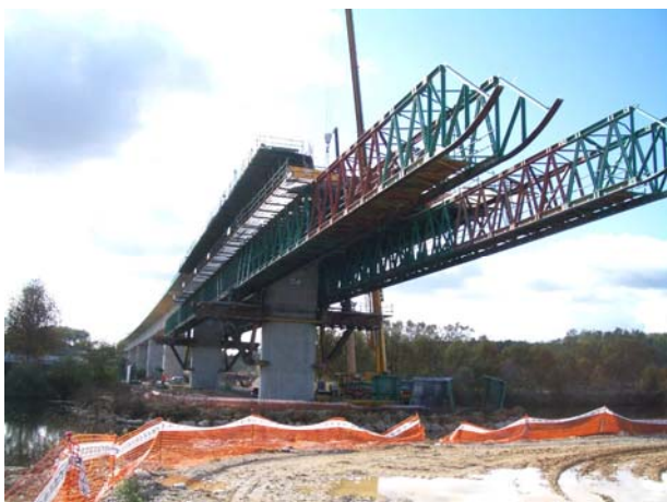
Figura 4: Construcción del tablero con autocimbra. Vista general.
