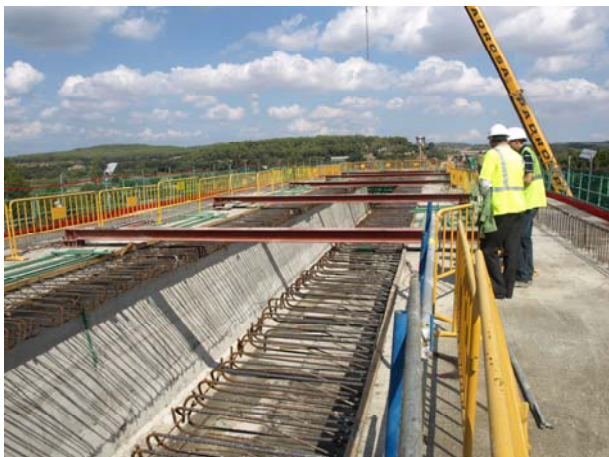
Figura 6: Arriostamiento provisional de la sección temporalmente abierta.
