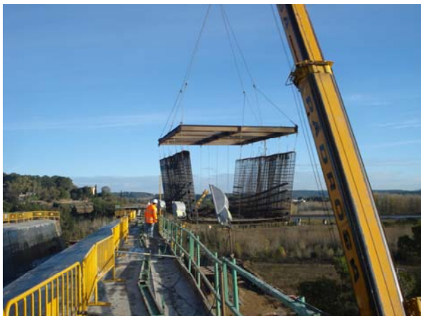
Figura 7: Izado de ferralla para montaje sobre autocimbra.
