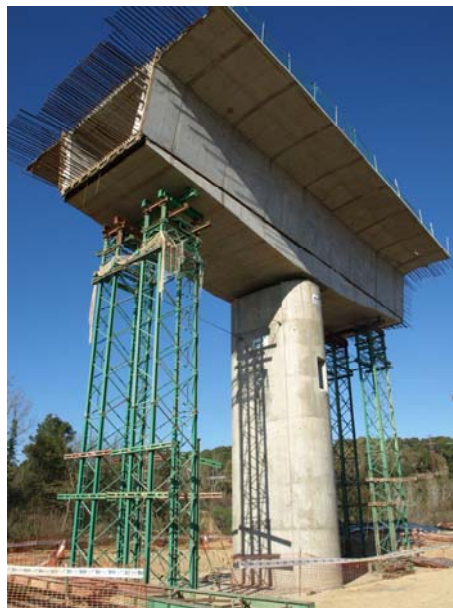
Figura 5: Ejecución de tramos de canto variable sobre cimbra y posterior estabilización.
