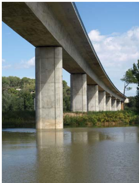
Figura 1: Vista general de la estructura en el cruce sobre el río.
